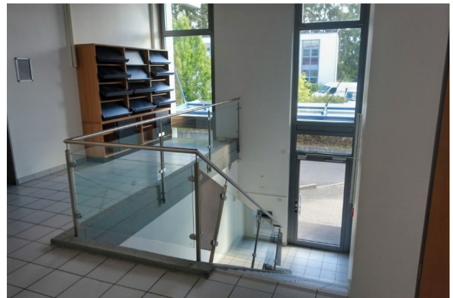
Treppenhaus sowie Ein- u. Ausgang
